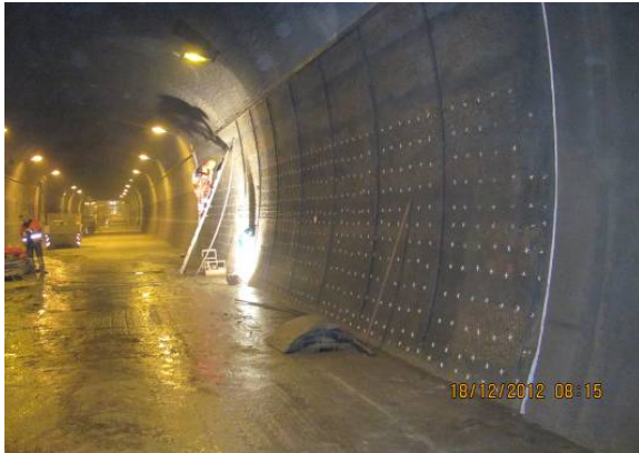
Bild 13: Montage der mischoxid-beschichteten Gitternetzanode an der Tunnelwand
