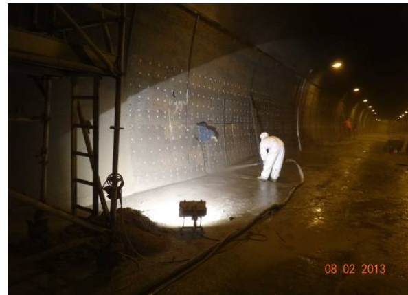
Bild 16: Einbettung der mischoxid-beschichteten Gitternetzanode
