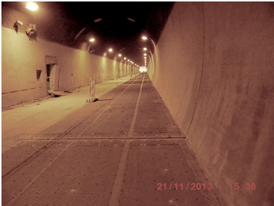
Bild 17: Blick in Tunnelröhre Ost nach SPCC-Applikation an den Wänden
