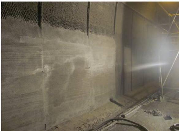
Bild 15: Applikation SPCC an Tunnelwand
